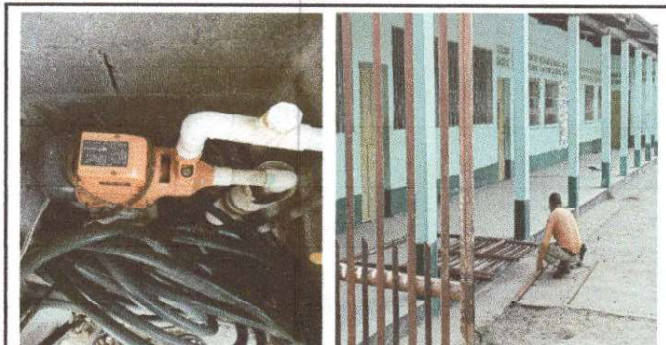
Foto 6: Limpieza y reparación de la Fosa Séptica.
