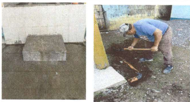
Foto 5: Sustitución de piso de torta de concreto.
