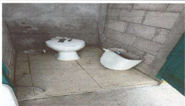
Foto 3: Reparación de la red de drenaje y limpieza de la fosa séptica, debido a que hay veces que el agua sale por debajo de los sanitarios.
