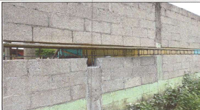
Foto 2: Reparación de muro perimetral, debido a que no existe un refuerzo para sostener el muro y corre el riesgo de caer.
